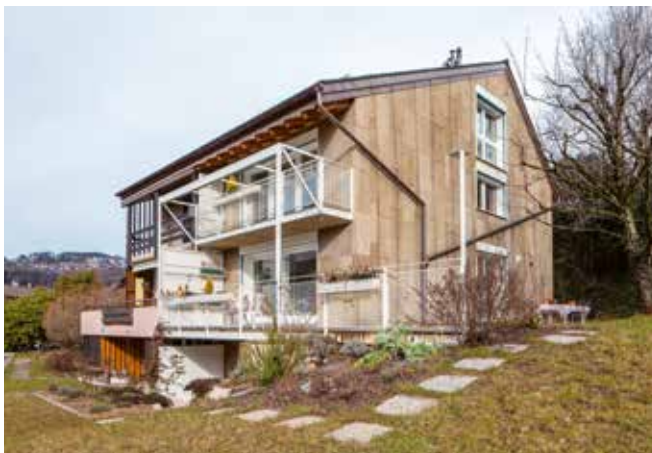
La couche de liège isole de la chaleur, tout en formant un revêtement de façade qui transforme l'apparence de la villa jumelle. Grâce à la stabilité dimensionnelle des panneaux, les joints de calepinage n'ont pas bougé après 2 ans. (LAETITIA GESSLER)
