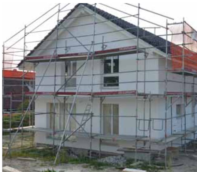
Étape 2 : mortier d'enrobage biologique sur isolation rigide en fibres de bois / peintre : Massard & fils / maison en ossature bois à Suchy
