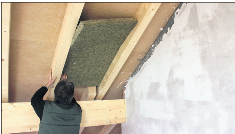
Après avoir été formés et découpés en usine, les panneaux sont posés entre chevrons. Ils peuvent cependant aussi être posés contre les murs, dans des parois intérieures et sous les planchers.
