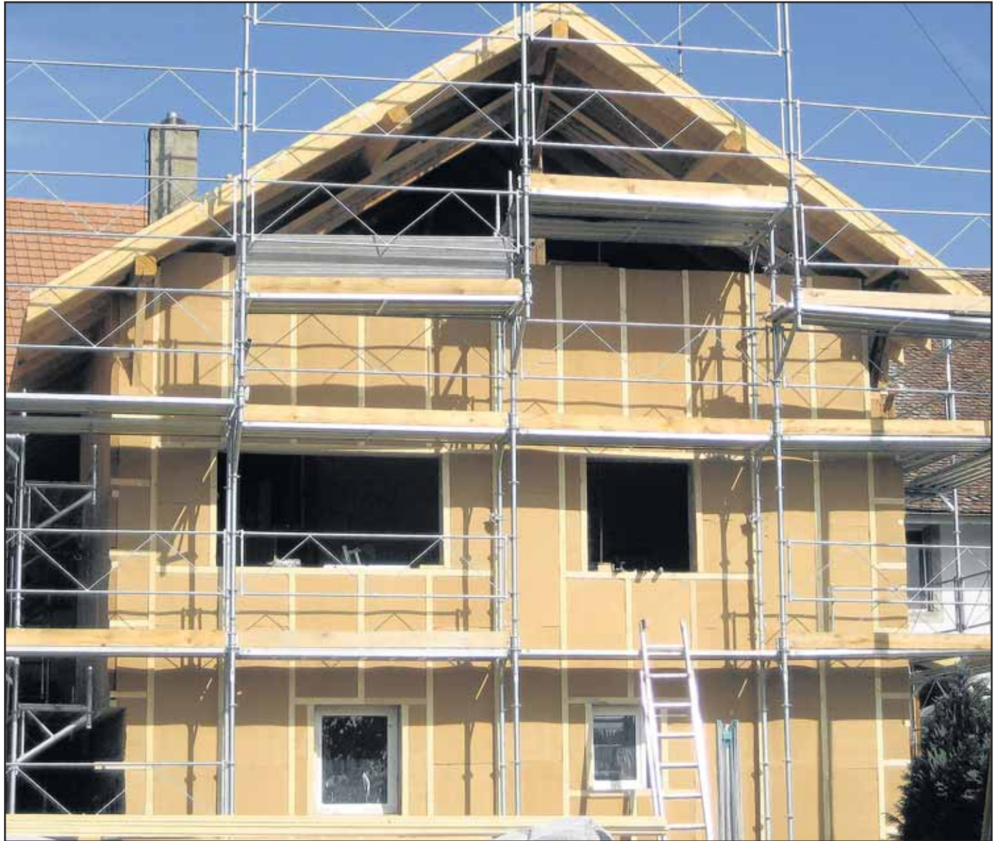
Isolation en fibres de bois avant la pose d'un coupe-vent et d'une façade ventilée. DR
