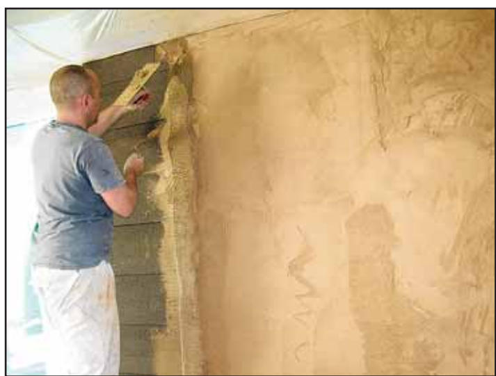
Crépi en terre crue sur plaques préfabriquées en terre crue.
