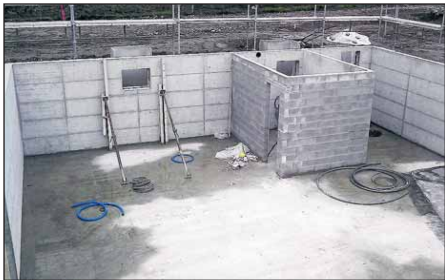
Avant le montage de l'ossature bois, les fondations ont été réalisées en béton armé.
