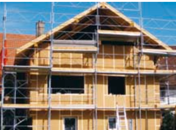
1. Isolation périphérique en laine de bois pour une façade ventilée.
