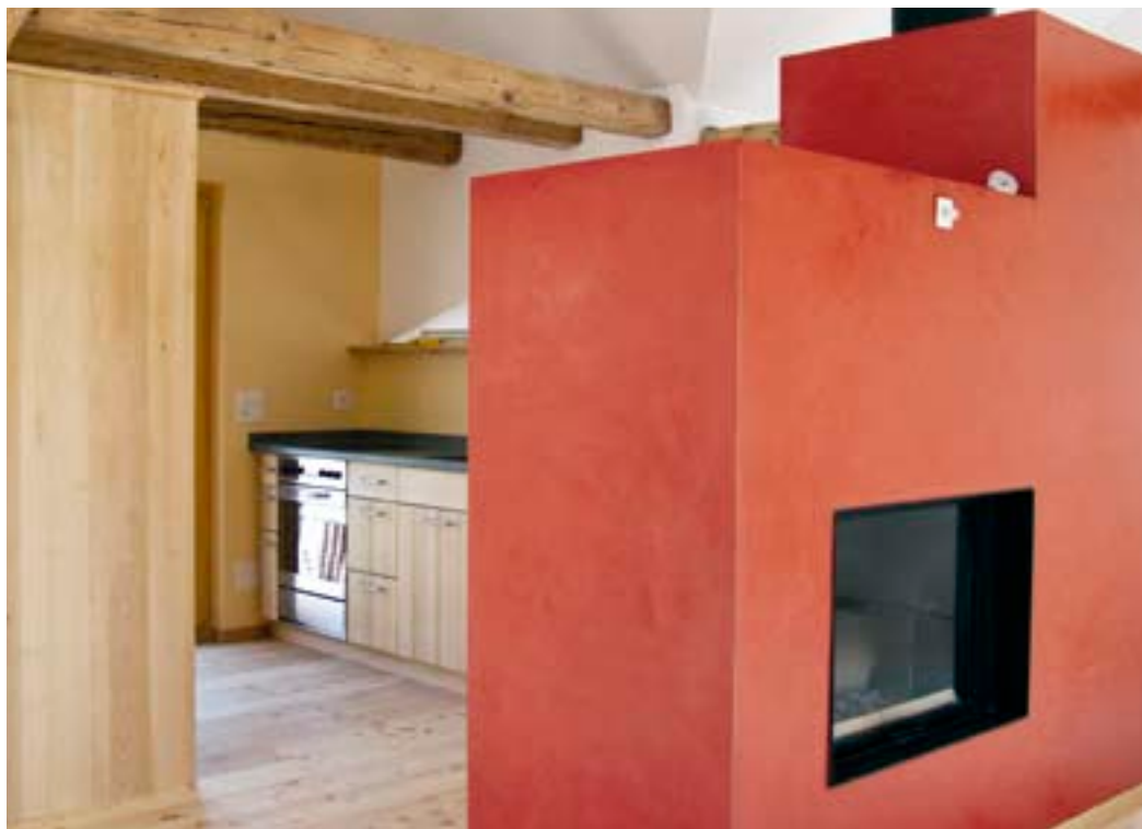
2. Enduit de finition en argile.
