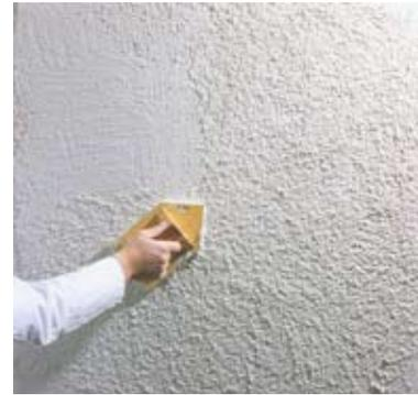
rendre rugueux avec un jet de truelle, projeter l'enduit sur le fond humidifié de manière homogène. Mettre en œuvre dans 4 heures. Ne pas appliquer à une température d'air et du mur inférieure à +5°C. Éviter l'exposition directe au soleil. Enduire les façades à l'ombre. Protéger la façade fraîchement peinte contre la pluie battante. Nettoyer les outils immédiatement et abondamment à l'eau après l'emploi.
