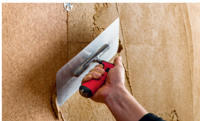
6. Appliquer une couche de mortier d'encollage à l'argile
