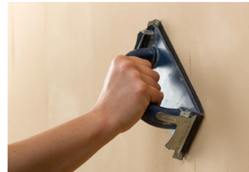
Fläche schleifen z.B. mit Schleifgitter P180
