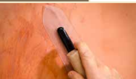
Compacter la surface avec la truelle japonaise en métal ou plastique.
