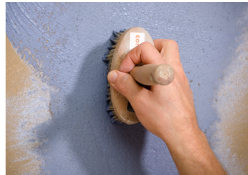
Lehm-Streichputz im Kreuzschlag auftragen
