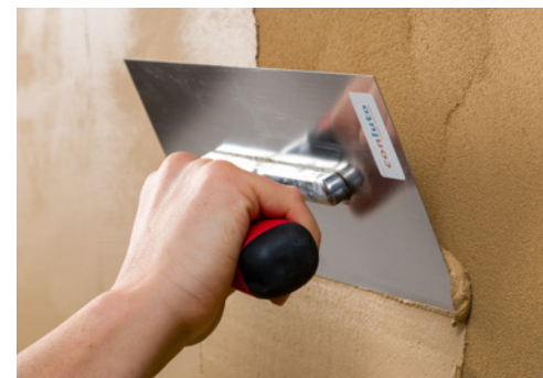
Spachtel vollflächig aufziehen
