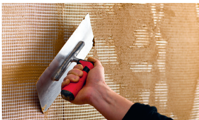
7. Intégrer et recouvrir la toile d'armature
