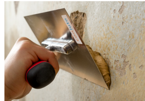
Löcher und Fehlstellen ausbessern
